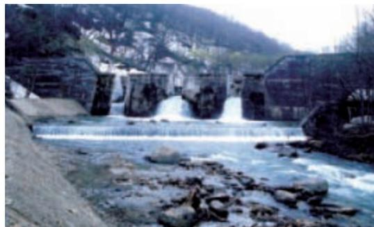
かつて整備した砂防ダムの堤体に切れ目を入れ、細かな土砂や水の透過を可能にした。（山形県：新井沢川ダム）
