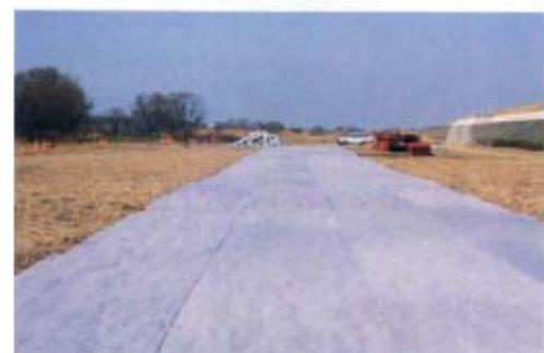
②工事用道路に搬入土を用いる場合にシートを敷いて土が混ざらないように配慮した例（長良川）
