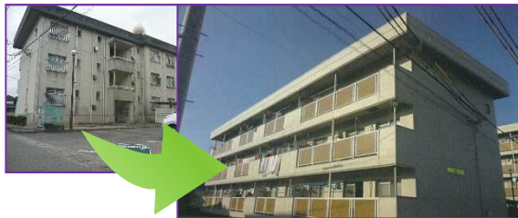
長寿命化改修事例（外壁改修）
