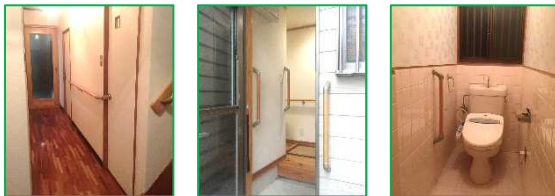
居住者の高齢化に伴う福祉リフォーム事例（手すり設置）
