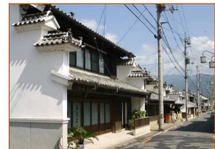
街なみ環境整備事業による修景事例
