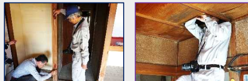
住宅のインスペクション(柱等の傾斜、雨漏り確認等)
