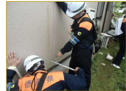
熊本地震における応急危険度判定
