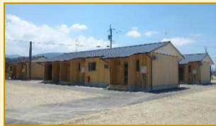
木造仮設住宅(熊本地震事例)
