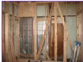
木造住宅の耐震改修事例
