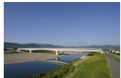
四国横断自動車道新那賀川橋（仮称）
