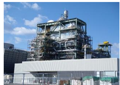
バイオマス発電所（クラボウ）
