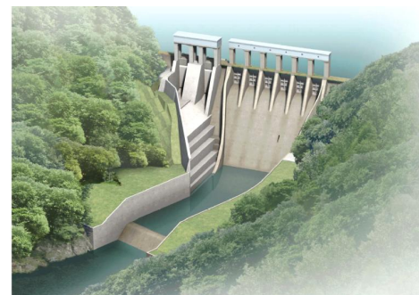
長安口ダム改造
