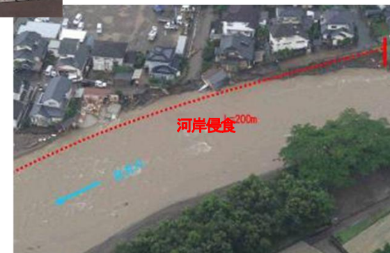
河岸侵食に伴う 家屋倒壊等
