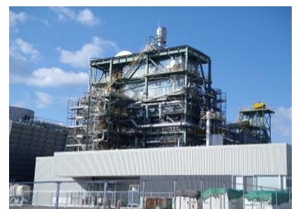
バイオマス発電所（クラボウ）
