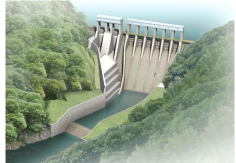
長安口ダム改造
