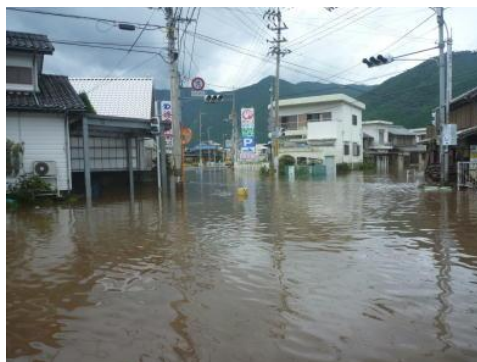
H26.7 鷲敷地区浸水状況
