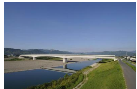
四国横断自動車道新那賀川橋（仮称）
