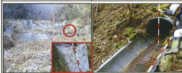
老朽化した堰堤
