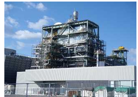
バイオマス発電所（クラボウ）
