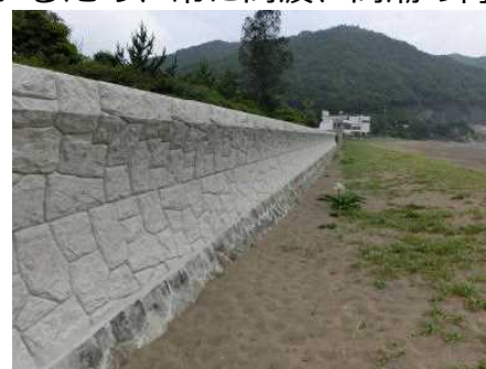
大浜海岸防潮堤
