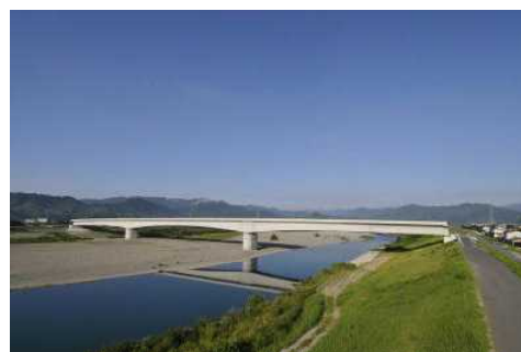
四国横断自動車道新那賀川橋（仮称）
