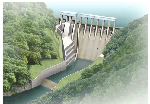
長安口ダム改造
