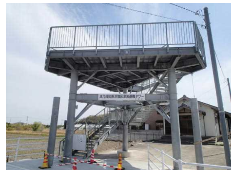
津波避難タワー
