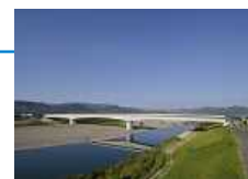
(仮称)新那賀川橋
