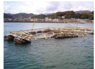
東日本大震災による津波で損壊したハマチ養殖施設(海陽町浅川)
