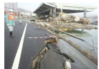
津波により瓦礫が押し寄せた魚市場（宮城県）
