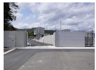
電動陸閘（牟岐漁港）
