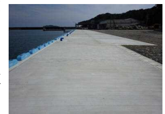
耐震岸壁（牟岐漁港）
