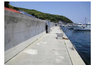
護岸（椿泊漁港）
