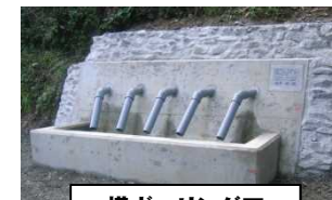
横ボーリング工
