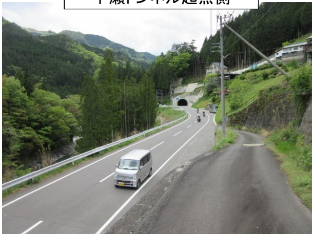
下瀬トンネル起点側
