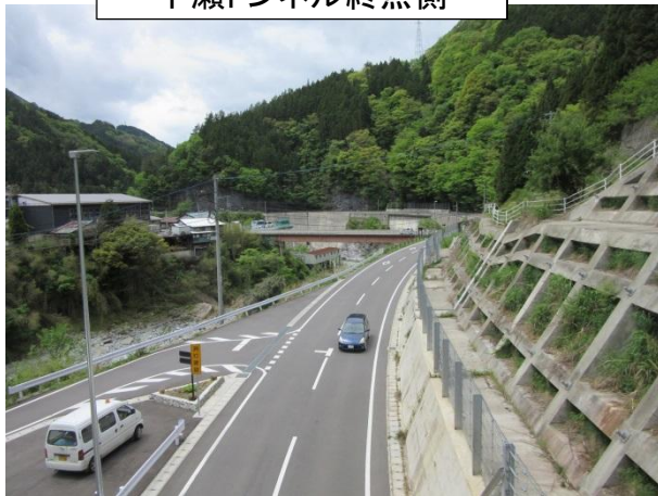
下瀬トンネル終点側
