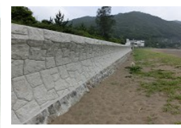
大浜海岸防潮堤
