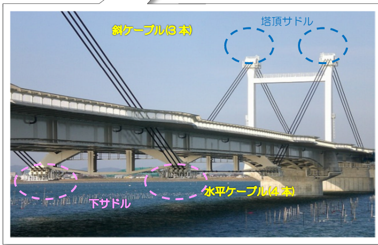
写真 1.1-1 各ケーブルとサドル部構造
