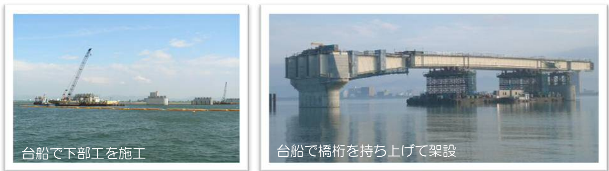
写真 1.2-2 台船施工方式
