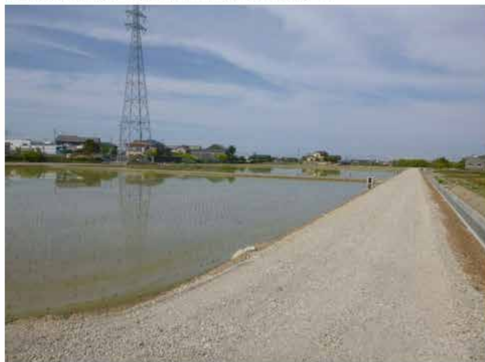
整備された農道(幅員4.0m)、用排水、農地
