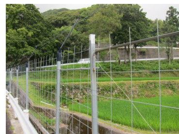
野生獣進入防止柵
