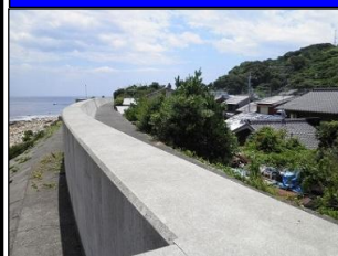
津波対策のための 海岸堤防の嵩上げ
