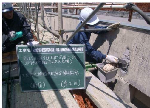
爆裂部 モルタル塗り仕上げ充填工法
