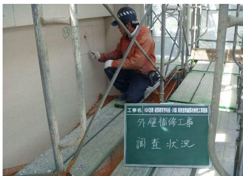
外壁補修 打診調査
