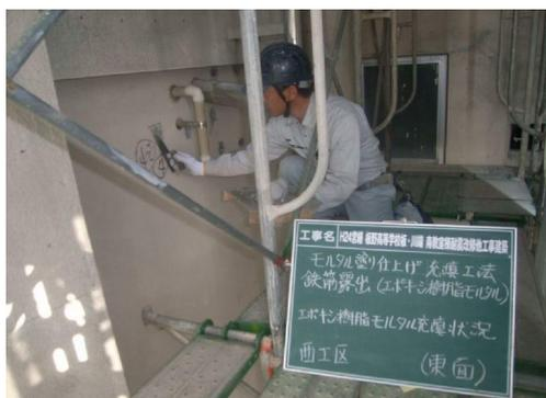
既存Uカット部 モルタル塗り仕上げ充填工法
