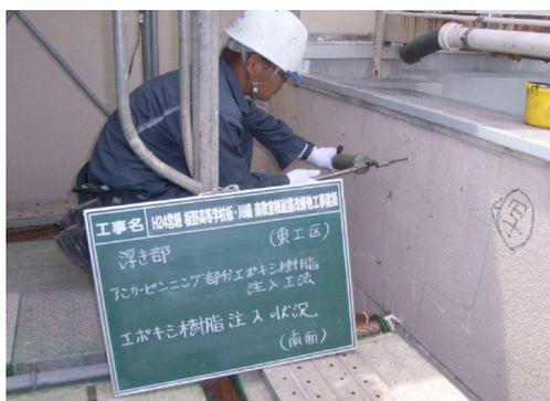
浮き部 アンカーピンニングエポキシ樹脂注入工法
