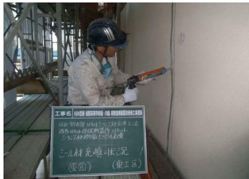
ひび割れ部 Uカットシーリング材充填工法
