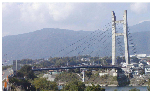
岩津橋 (平成5(1993)年、斜張橋、175m) 2車線・片側歩道
