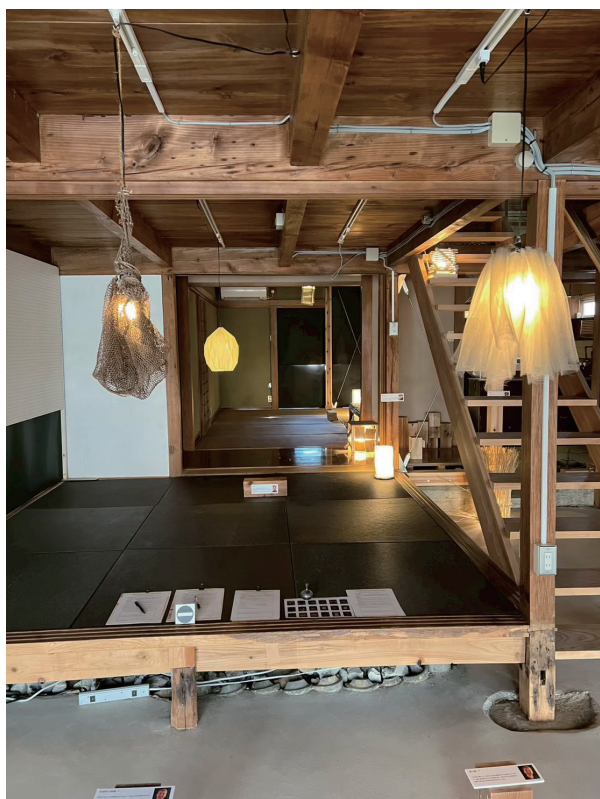
1F 土間から全体を見る
