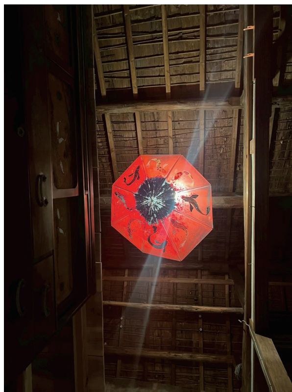
1F 土間から全体を見る
