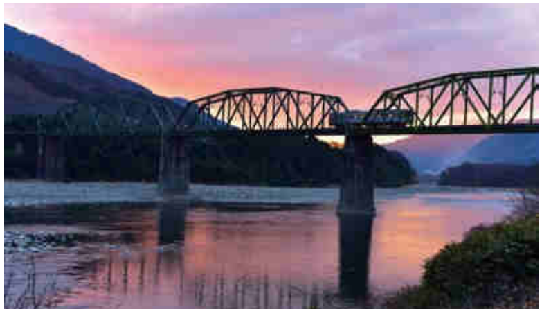
吉野川橋りょう(土讃線)
