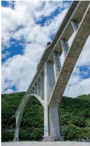
池田へそつ湖大橋
