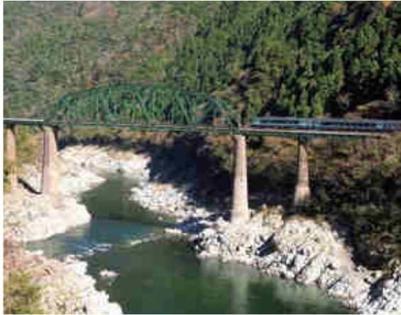
現在の第2吉野川橋りょう(土讃線)
