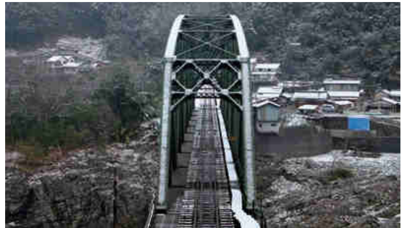
第1吉野川橋りょう(土讃線)
