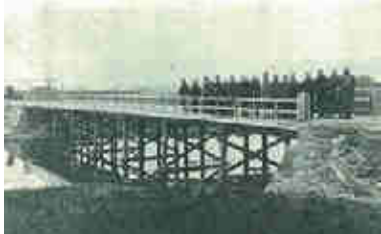
高瀬渡しに一時期架けられた木製の潜水橋(賃取り橋)(石井町史)
