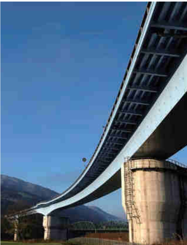
吉野川橋(徳島自動車道)
