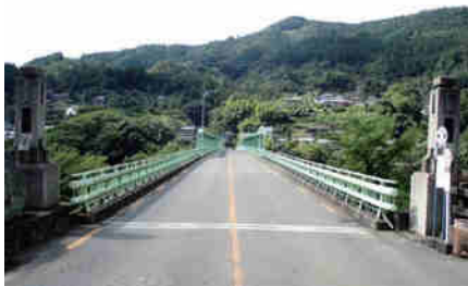
写真-10 三好橋(アーチ橋)
