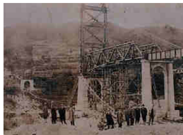
写真-12 三好橋の橋桁架設(三好市教育委員会提供)
