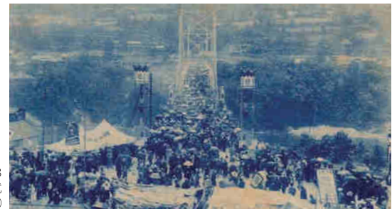
写真-3 昭和2年5月に完成した三好橋の開通式 (公益社団法人 土木学会附属土木図書館所蔵)
