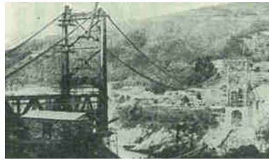
写真-13 三好橋の橋桁架設(三好市教育委員会提供)
