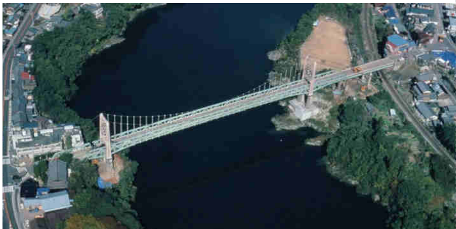
写真-1 昭和2年5月に架設された三好橋
