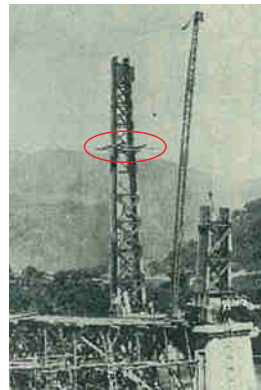
写真-11 三好橋の主塔の架設 (三好市教育委員会提供)
