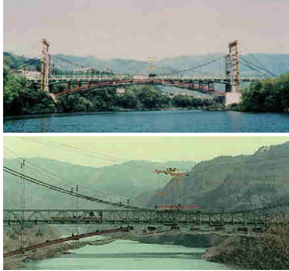
写真-15 ケーブルエレクション工法によるアーチ橋の施工(写真下)(大岩義雄氏提供)
