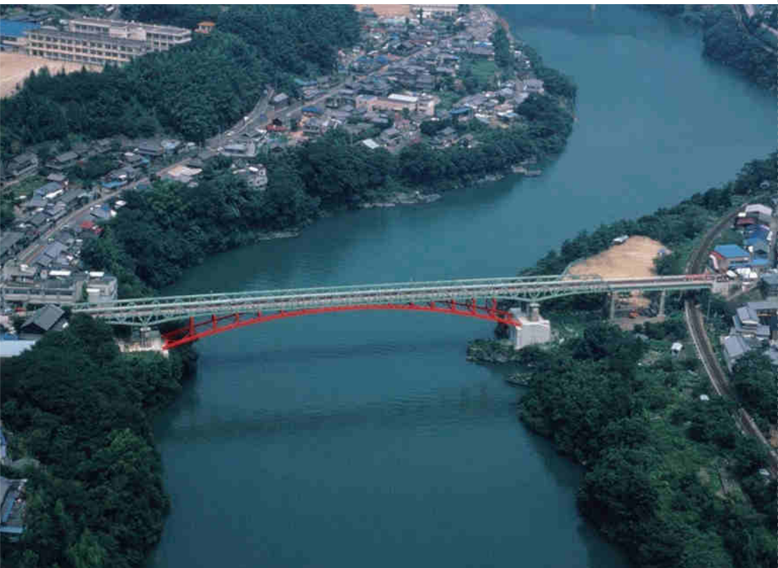
写真-2 三好橋（平成元年8月にリニューアルされたアーチ橋）
