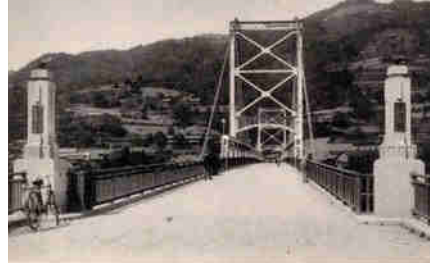
写真-9 架設当時東洋一の吊橋であった三好橋 (公益社団法人 土木学会附属土木図書館所蔵)
