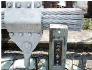
写真-16 保存された三好橋のメインケーブル
