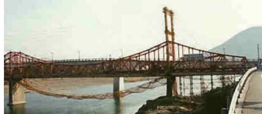
写真-19 解体撤去中の穴吹橋 (大岩義雄氏提供)
