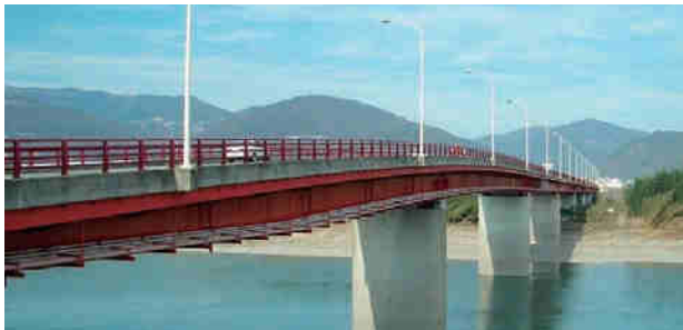
写真-16 現在の穴吹橋
