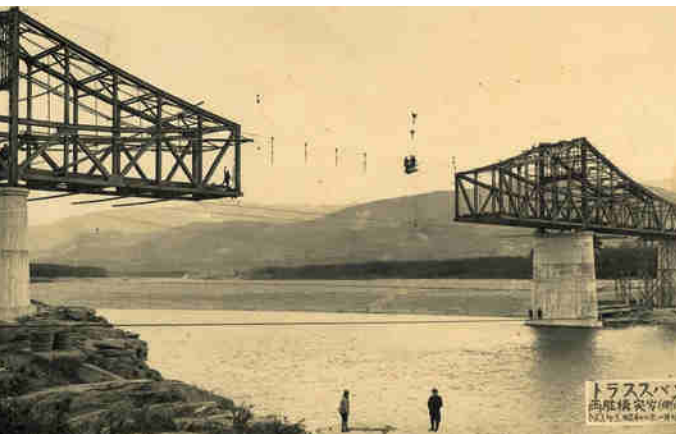
写真-15 トラス橋の架設状況(中央径間)(美馬市提供)
