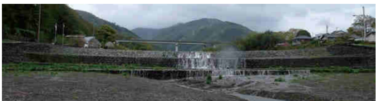
写真-11 大谷川堰堤（デ・レイケの堰堤）
