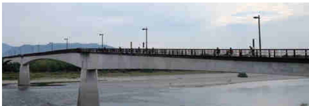
写真-18 平成4年に架設された「ふれあい橋」
