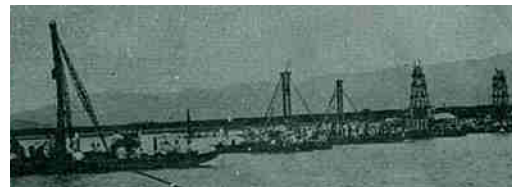
写真-8 工兵隊による木橋の架設(写真集 吉野川百年史資料編)
