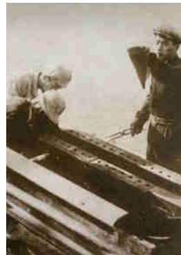
写真-28 鉸鉸作業 (阿波中央橋架設工事報告書)
