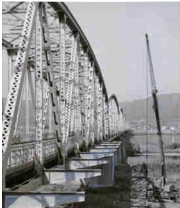
写真-10 自歩道橋の架設(徳島新聞社提供)
