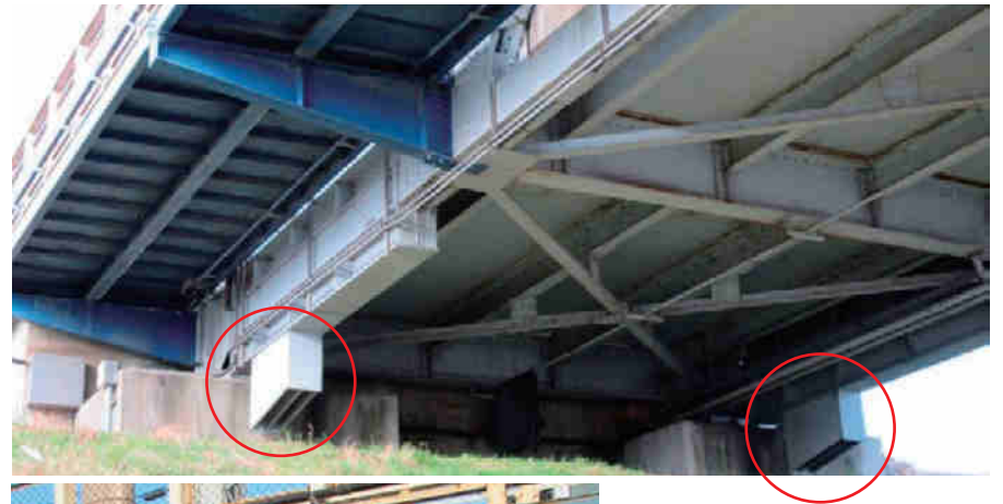
写真-31 伸縮装置の補修
