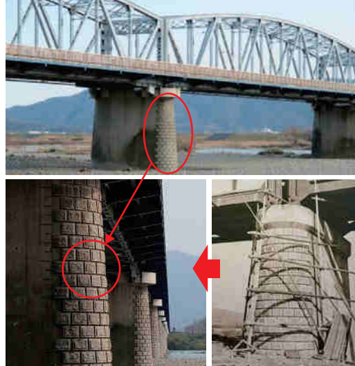
写真-21 橋脚の石張りによる防護(右下の写真は阿波中央橋架設工事報告書より)
