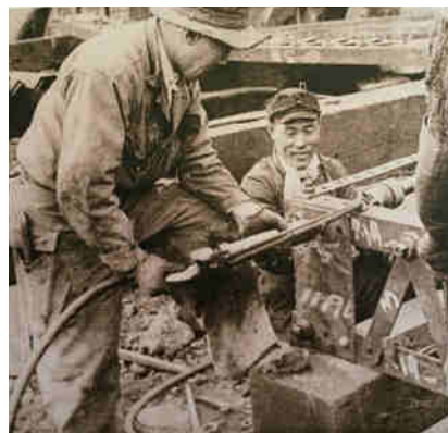
写真-23 工場内での鉸鉸作業(阿波中央橋架設工事報告書)
