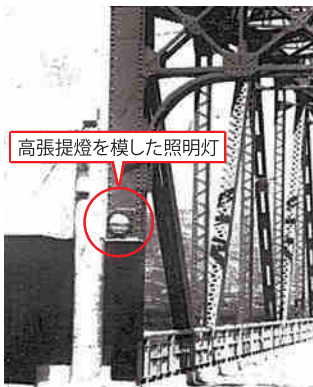
写真-14 完成時の阿波中央橋 （阿波中央橋架設工事報告書）
