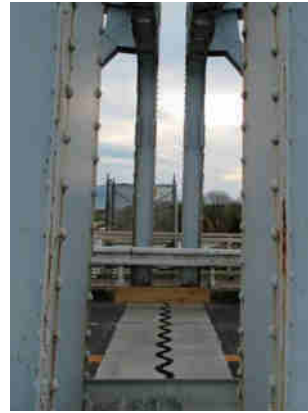
写真-31 伸縮装置の補修
