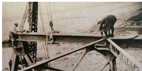
写真-27 クレーンによる上弦材の組み立て (阿波中央橋架設工事報告書)
