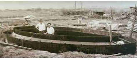
写真-18 橋脚の井筒杓(阿波中央橋架設工事報告書)
