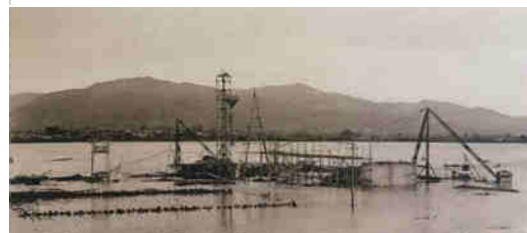
写真-5 キジア台風による被害 (昭和25年9月12日) (阿波中央橋架設工事報告書)
