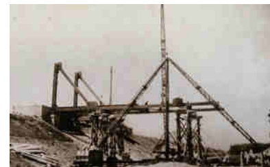
写真-26 クレーンによる下弦材の組み立て (阿波中央橋架設工事報告書)
