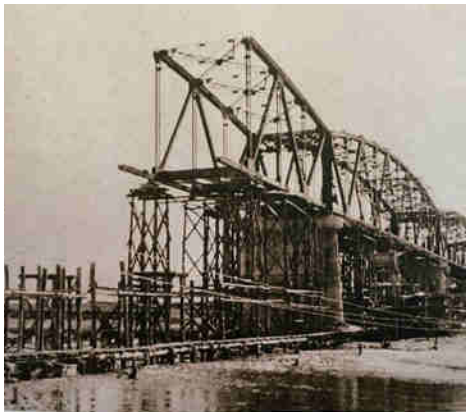
写真-24 架設支保工(阿波中央橋架設工事報告書)
