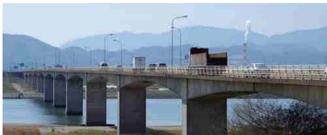
写真-4 北岸側から名田橋を望む
