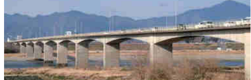
写真-10 下弦に曲線を持つ名田橋
