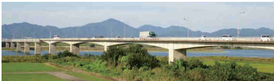
写真-3 南岸側から名田橋を望む
