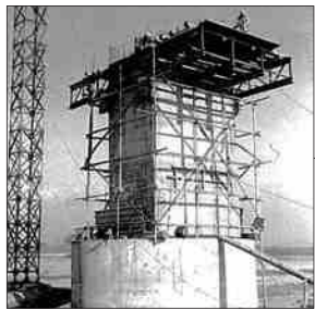
写真15 柱頭部の構築(名田橋工事報告)
