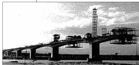
写真18 左右バランスをとりながら橋桁を伸ばす(名田橋工事報告)
