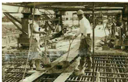
写真-22 ワーゲン内におけるコンクリート施工状況(名田橋工事報告)
