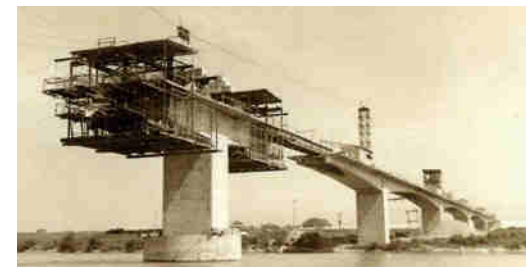
写真13 上部工の施工状況(名田橋工事報告)
