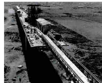
写真-19 運搬設備(名田橋工事報告)
