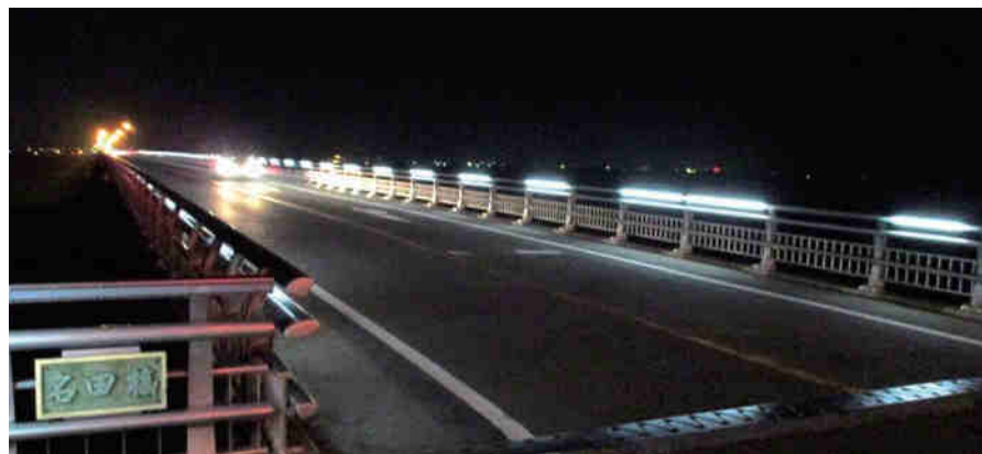
写真-26 LED照明灯を内蔵した高欄
