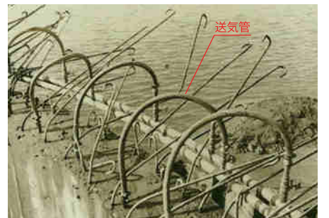
写真-24 送気管の取り付け(名田橋工事報告)
