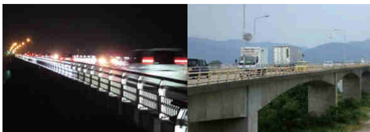
写真-6 昼・夜を通じて通行車両の多い名田橋
