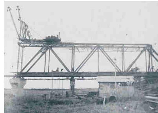
写真4 トラス橋の架設（片持工法による架設）（徳島新聞社提供）
