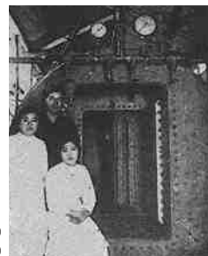
写真-6 マンロック(加圧・減圧設備)(公益社団法人土木学会附属土木図書館所蔵)
