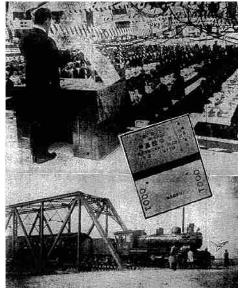
写真-2 吉野川橋りょう(高德線)の開通時の写真(徳島新聞社提供)
