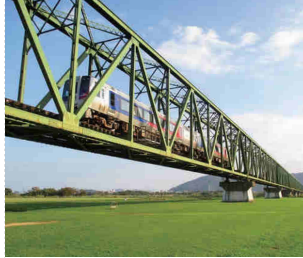
写真-3 モスグリーンに彩られた吉野川橋りょう(高德線)
