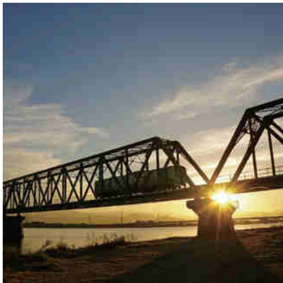
写真-16 吉野川橋りょう(高德線)
