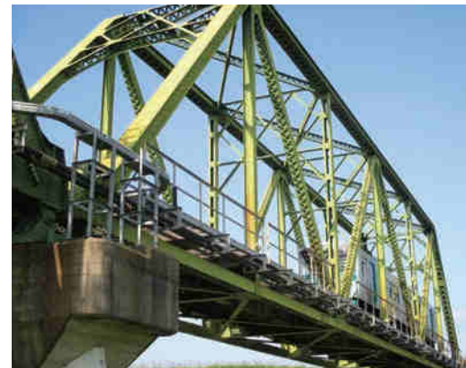
写真5 3径間連続トラス橋と単純トラス橋との高さ調整により景観に配慮
