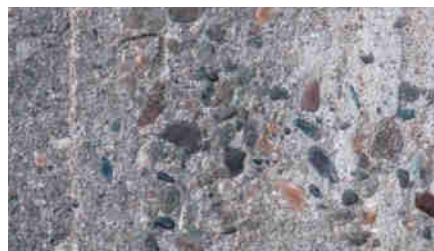
写真-26 橋脚のコンクリート表面 (吉野川橋)
