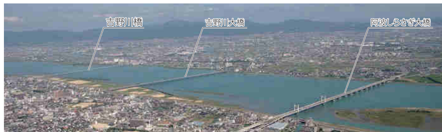
写真-3 上流から吉野川橋、吉野川大橋、阿波しらすぎ大橋
