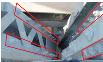
写真-18 高力ボルトによる接合
