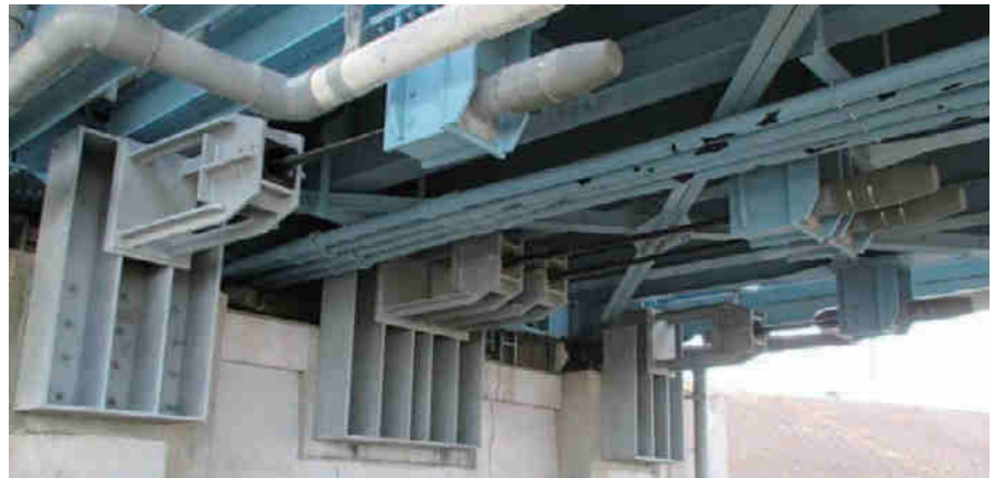
写真-27 大規模地震により落橋しないための対策
