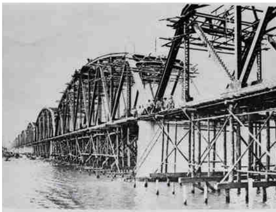
写真-16 現場鉸鉸状況（吉野川橋工事概要）
