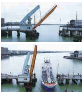
写真-19 旧加賀須野橋（上）可動中（下）船舶通行時
