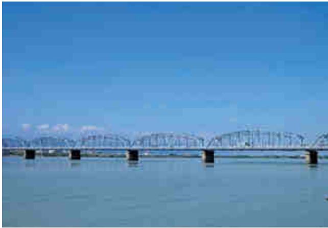
写真-4 吉野川橋
