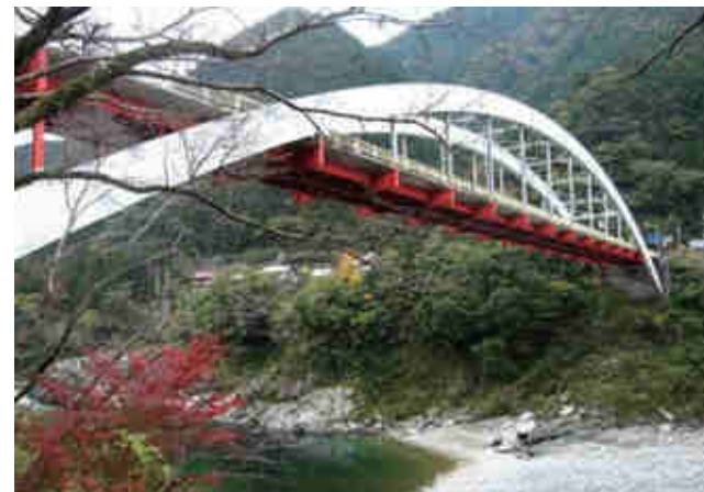
写真-7 大歩危橋
