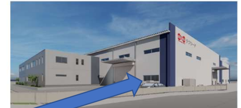
EVチャージャー
