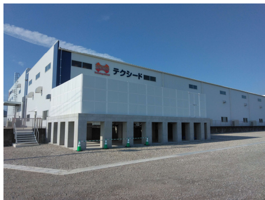
蓄電池収納場所
