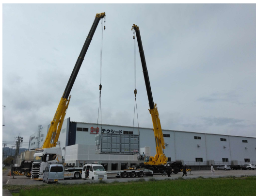
大型蓄電池搬入
