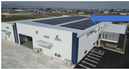
太陽光パネル
