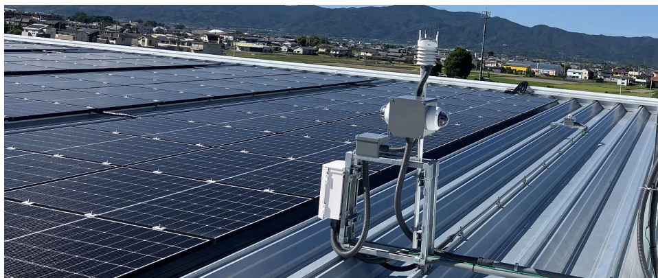
環境観測センサ/日射センサ/空観測カメラ
