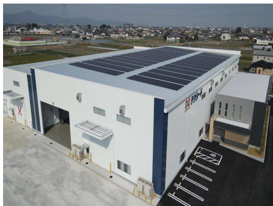
太陽光パネル
