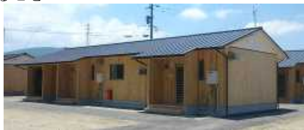
木造応急仮設住宅
