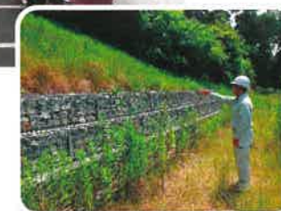
▲治山施設の点検
