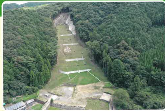
復旧状況 令和5(2023)年9月
