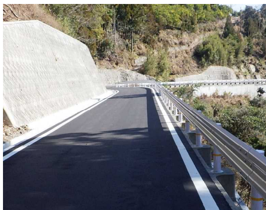
農道の整備 (徳島県東部3期地区 上勝町)
