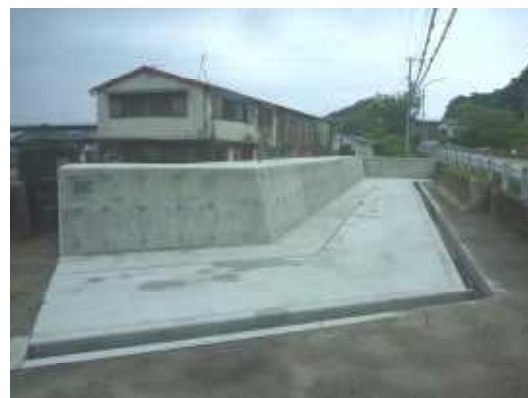
海岸保全施設の耐震・耐津波化 (穴喰漁港海岸 海陽町)
