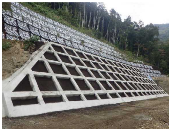
地すべり防止施設の整備 (井ノ久保地区 三好市)
