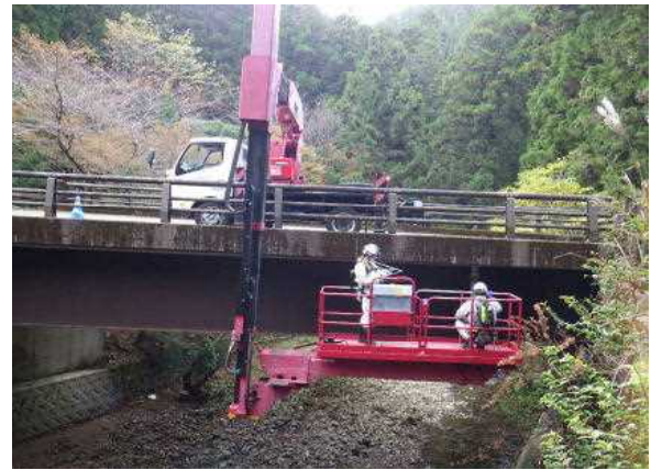
土地改良施設（農道橋）の点検 （那賀町）
