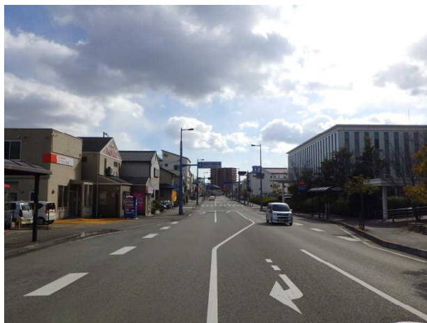
市街地再開発事業に合わせた無電柱化 (県道33号小松島佐那河内線)
