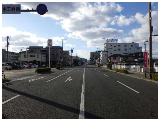
緊急輸送道路の無電柱化 (県道 38 号 沖ノ洲 徳島本町線)
