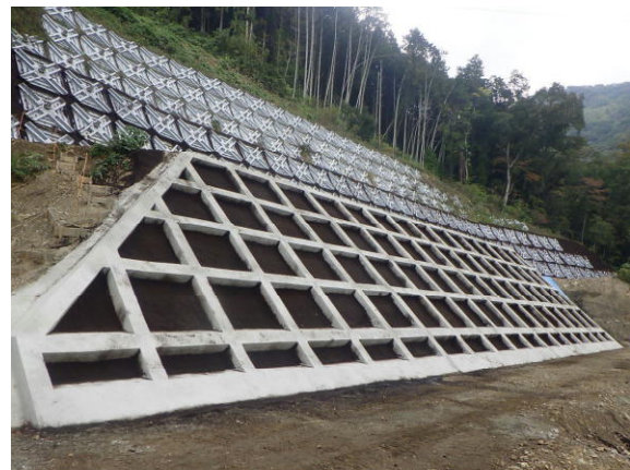
地すべり防止施設の整備 (井ノ久保地区 三好市)
