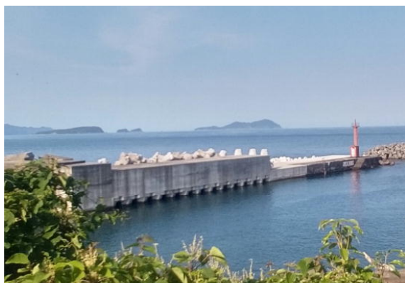
漁港施設の耐震化 (鞆奥漁港 海陽町)
