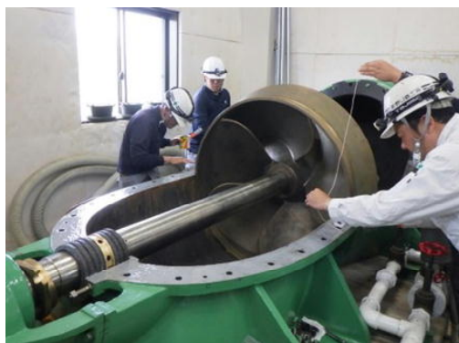
排水機の長寿命化 (川内近藤地区 徳島市)
