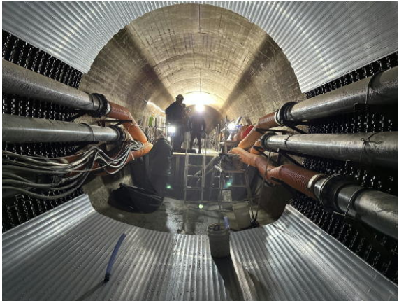
農業用水路トンネルの耐震化 (東みよし町)
