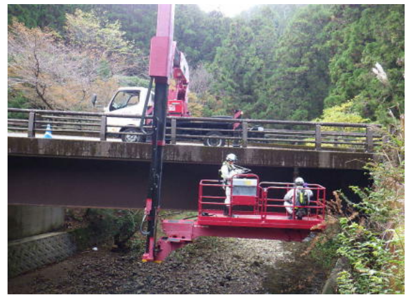
土地改良施設（農道橋）の点検 （那賀町）
