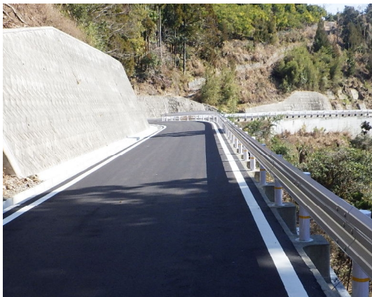
農道の整備 (徳島東部3期地区 上勝町)
