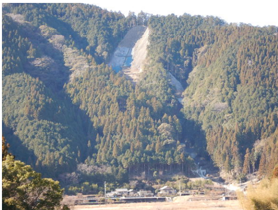
治山施設の整備 (三箇地区 海陽町)
