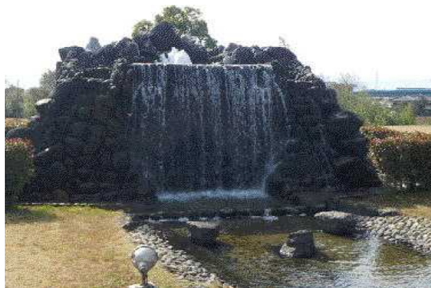
浄化用水ポンプ
