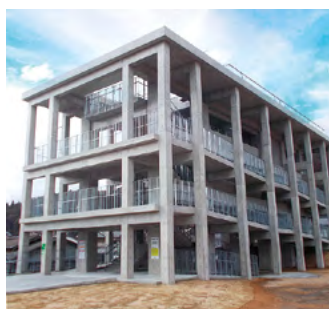
津波避難タワー
