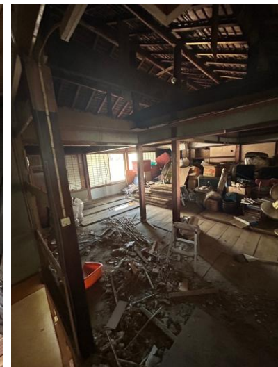
解体作業中 2階
