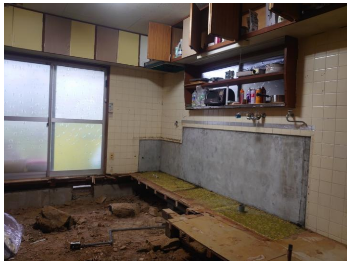
解体作業中 1階
