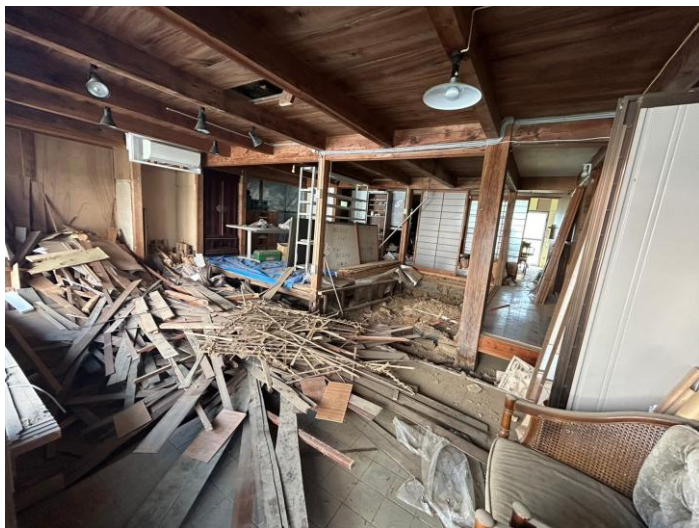
解体作業中 1階
