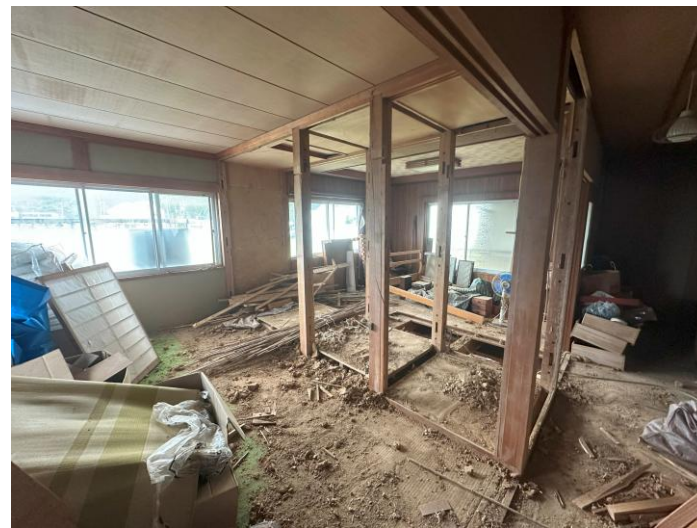
解体作業中 2階
