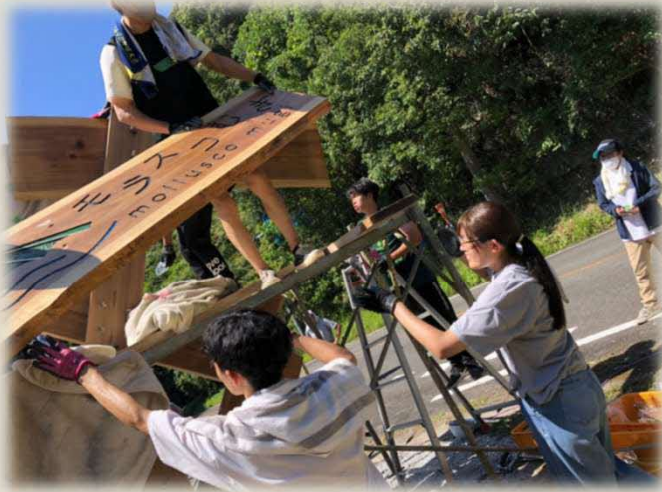
足場を組み立てて 作業
