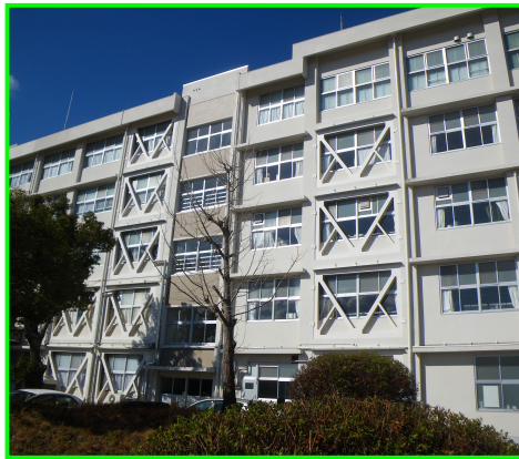
急ピッチで進んできた 構造体の耐震化
