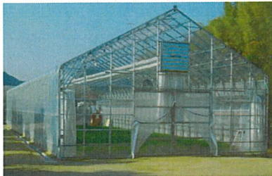
足場管ハウス
