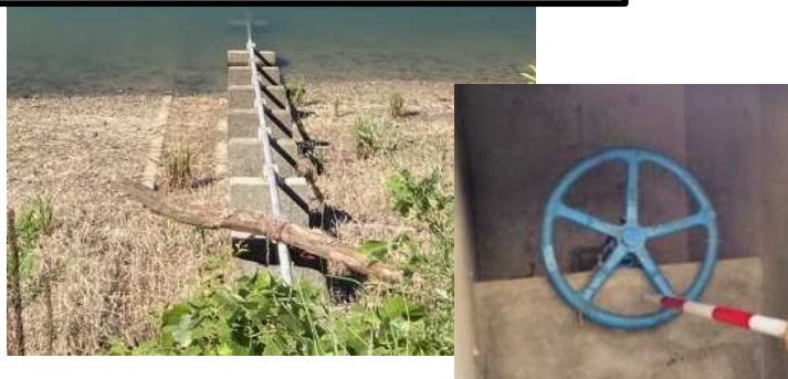
取 水 施 設 ・ 斜 樋（ 現 況 ）
