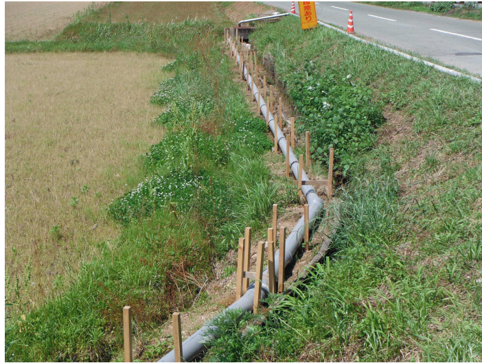
図4－5 仮廻し水路の状況
