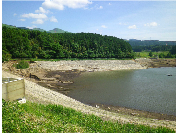
図4－7 緊急的に水位を下げたため池
