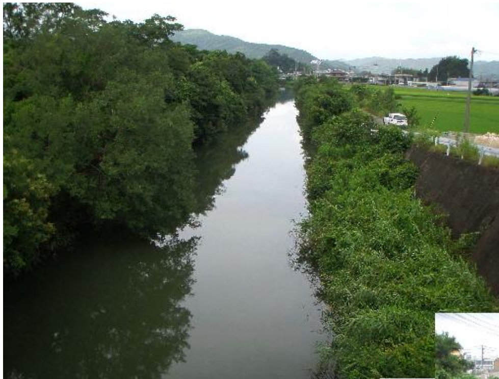
未整備排水路の状況
