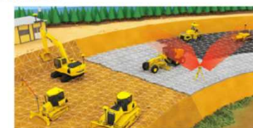
ICT活用工事
