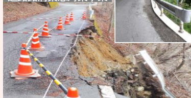
道路路肩緊急対策事業
