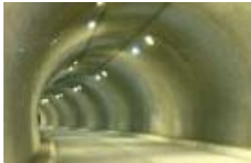
折宇トンネル(国道 195号)
