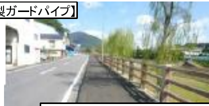
県道 大谷脇線(デレーケ堰堤付近)
