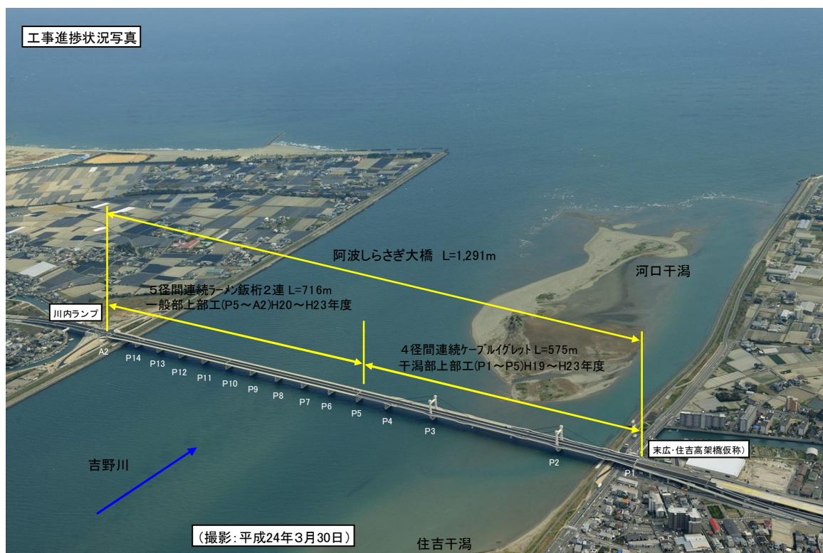
写真 1-1 工事区域全景 上空より（平成24年3月）
