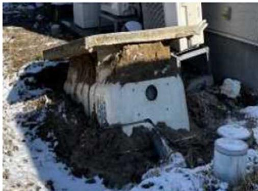
地震により浮き上がった浄化槽（画像は七尾市内の例）
