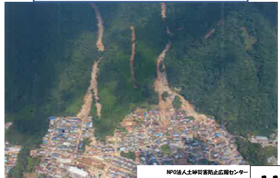
2014年 広島土砂災害(広島県広島市)
