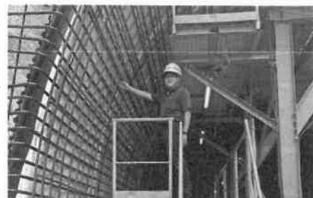
阿南市で建設中の色面トンネルを視察(2023.7.14)
